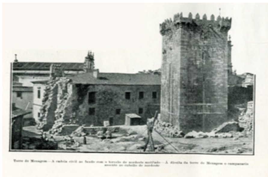
Figura 2: Torre de Menagem – cadeia civil e torreão de nordeste mutilado
