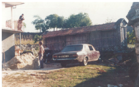
Figura 20 – Construção de casa de emigrante nos períodos de férias durante os anos de 1974 a 1977 (Lugar de Lamalonga, freguesia de Campos – Vieira do Minho) Fonte: Fotografia cedida por António Barroso
