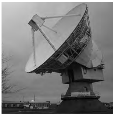
Antena terrestre para emissão de sinais ao satélite.
