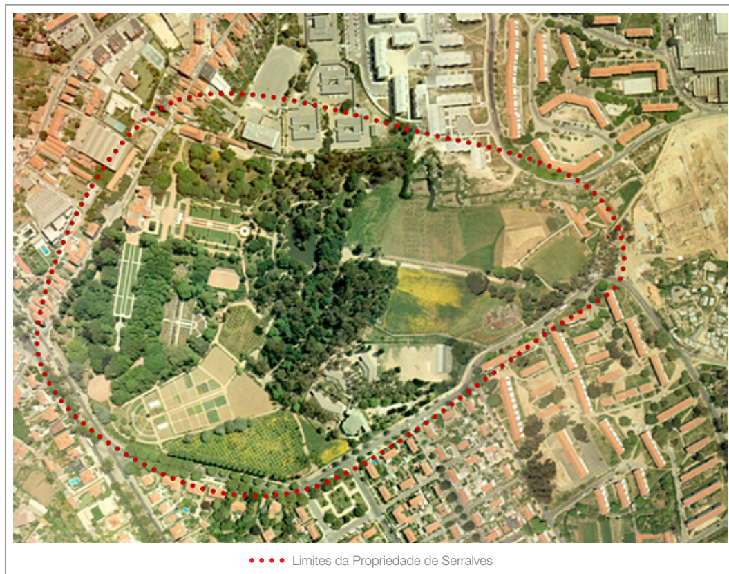
Figura 1. A Propriedade de Serralves (Sem o Museu Contemporâneo de Serralves) – Vista Aérea. Fonte: (Autor desconhecido). Faculdade de Arquitectura da Universidade do Porto, década de 80, século XX.
